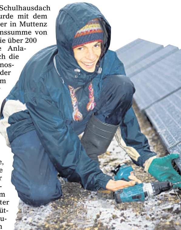
Jonas Rosenmund bei der Arbeit auf dem Schulhausdach.
